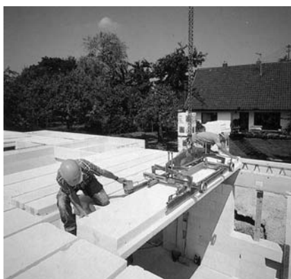
Рис. 28. Захват для укладки плит перекрытия
